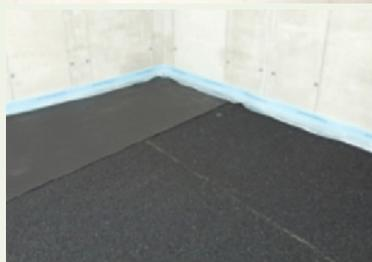
2. **SPEBA DAMTEC-system** Dämmunterlage vollflächig im Raum mit Granulaten nach oben, auslegen und etwas größer zuschneiden. Die zweite Lage **SPEBA DAMTEC-system** wird mit Granulaten nach unten ebenfalls vollflächig aber versetzt zugeschnitten und ausgelegt. Den Belag einen Tag (mind. 24 Stunden) entspannen und akklimatisieren lassen.
