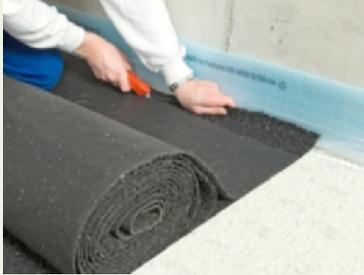
3. Zum Zuschneiden kann ein Cutter Messer verwendet werden. Als Hilfe ist ggf. eine Anlegeschiene zu nutzen.
