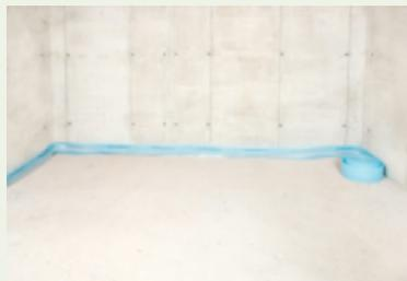
1. Untergrund gründlich abfegen. Um Schallbrücken zu vermeiden ist vor Einbringen der Elemente für den Fußbodenaufbau zu allen aufgehenden Bauteilen, wie Wänden, Rohrleitungen und anderen ein Randdämmstreifen zu verlegen. Der Randdämmstreifen muss ausreichend dimensioniert sein und bis über die fertige Oberbelagshöhe gezogen werden.
