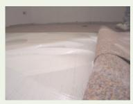
4. **SPEBA DAMTEC-resistant cork G** mit der ungeschliffenen Seite oder **SPEBA DAMTEC-resisten cork** faltenfrei in das Klebstoffbett einlegen und sorgfältig anreiben und anwalzen. Die zweite Hälfte des Raumes auf die gleiche Weise bearbeiten.
