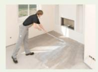
Untergrund gründlich abfegen oder absaugen. Zum Ausgleich von Unebenheiten die Untergründe mit geeigneten Vorstrichen oder Grundierungen behandeln und mit geeigneten Spachtelmassen ausgleichen.
