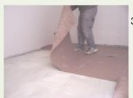
3. SPEBA DAMTEC-resistant cork (G) passgerecht zuschneiden, zur Mitte des Raums zurückschlagen und die Verklebung der Unterlage nach den Vorgaben der Kleberhersteller durchführen. Bei SPEBA DAMTEC-resistant cork G muss die geschliffene Rolleninnenseite nach der Verlegung oben sein.
