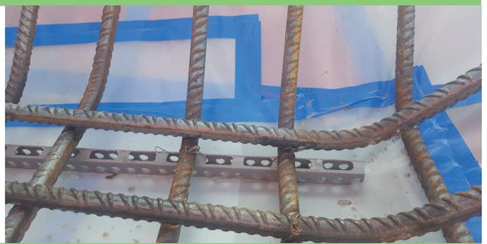
Bei großen Flächen ist es zu empfehlen, dass hier zuerst eine 9 cm dicke Schicht aufbetoniert wird, da diese dann als Lastverteilerschicht fungieren kann um den gewünschten Erfolg zu erzielen.
