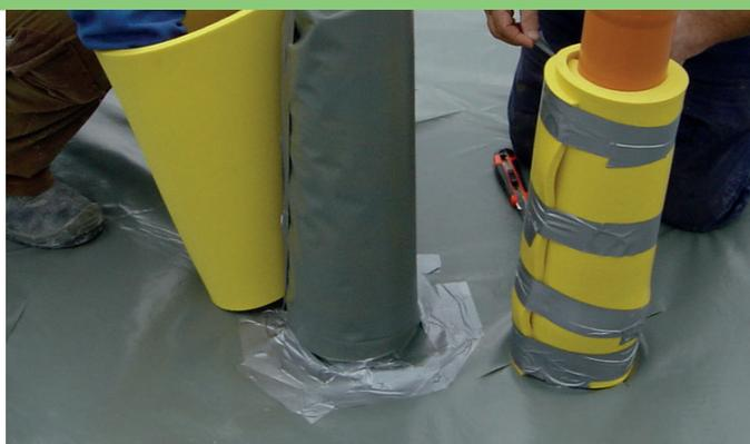
Nachfolgend wird eine PE-Folie verlegt und vor dem Randdämmstreifen bis über die fertige Oberbelagshöhe hochgezogen. Die Folie sollte fixiert werden, um ein Verschieben während des Betonierens zu verhindern.
