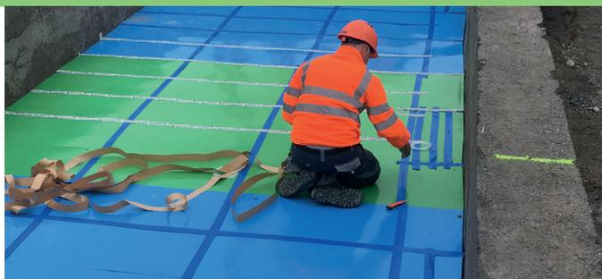
Im Falle einer mehrlagigen Auslegung sollen die einzelnen Lagen versetzt zueinander verlegt werden.
