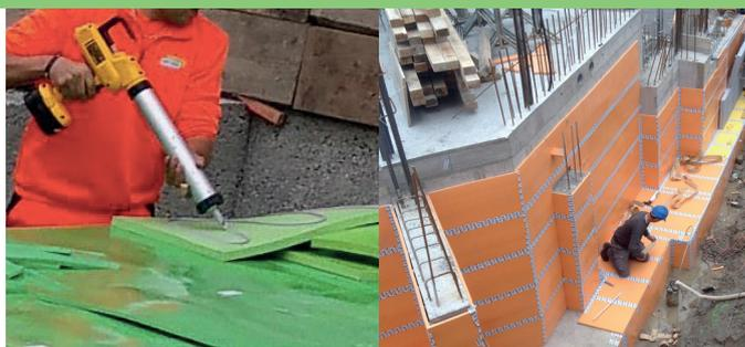
Anschließend sollen alle Stöße mit einem ausreichend breitem Klebeband überklebt werden. Dadurch wird vermieden, dass die Betonmilch zwischen den Matten eindringt und eine Körperschallbrücke bildet.
