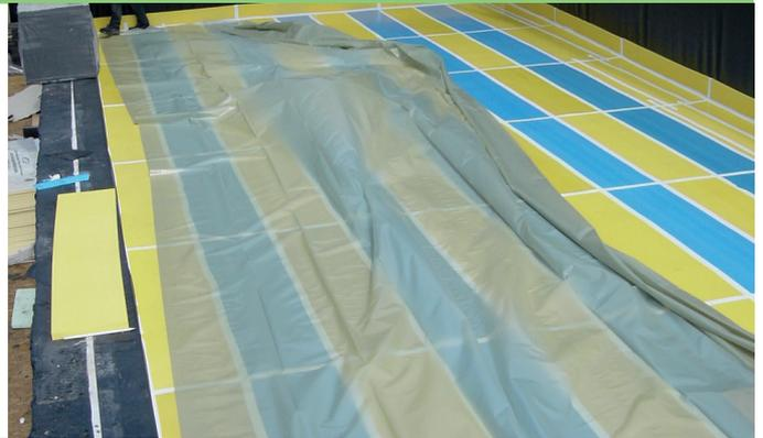
Um das Betonieren zu erleichtern, müssen hier Abstandhalter für die Bewehrung eingebracht werden. Zusätzlich wird hierdurch auch verhindert, dass sich Abdrücke in den Matten abbilden, welche im Nachhinein einen Einfluss auf die Isolierwirkung hätten.
